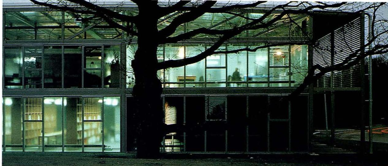
Au moment de la construction, l'assemblage des matériaux est fait à sec (par exemple, par boulonnage) et non par collage. L'emploi d'aluminium est réservé uniquement aux éléments fortement exposés aux intempéries. L'absence de traitement et de collage permet le démontage, la réutilisation future ou le recyclage de tous les éléments constitutifs du bâtiment.
