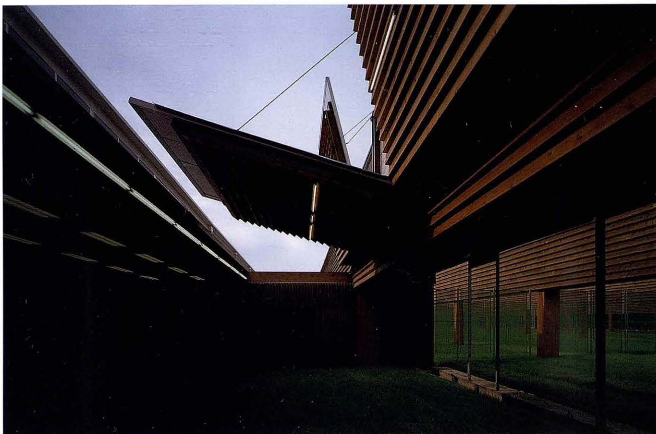
Galeries de tir. Seccions longitudinals amb les planxes mòbils sobre la zona de finals (galeria de 50 metres) que regulen l'entrada de llum i els panells de formigó amb lames de fusta sobre els carrers de tir Shooting galleries. Longitudinal sections with the mobile elements over the finals zone (50-meter gallery) used to control daylight and the concrete and wooden panels over the shooting row
