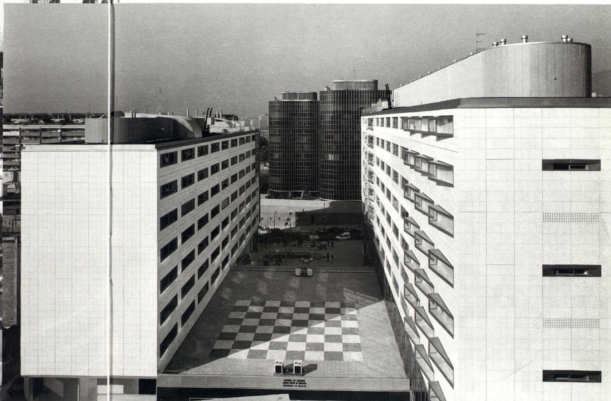
Gran Via Carles III — carrer Joan Güell Edifici Mixt (1993) Arquitectes Josep Lluís Mateo amb Jaume Arderiu, Josep M. Crespo Edificis Trade (1969) Arquitecte José Antonio Coderch, Manuel Valls
