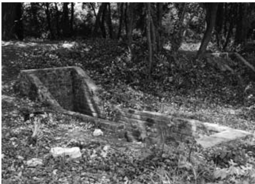
Estat actual d'un dels refugis elementals de Cardedeu (Fotografia: D. Gesalí.)
