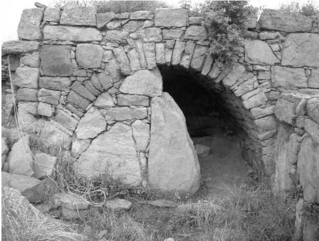
Construcció de pedra seca amb volta de canó obrada per conservar una mina d'aigua Fonllosa (Bages)
