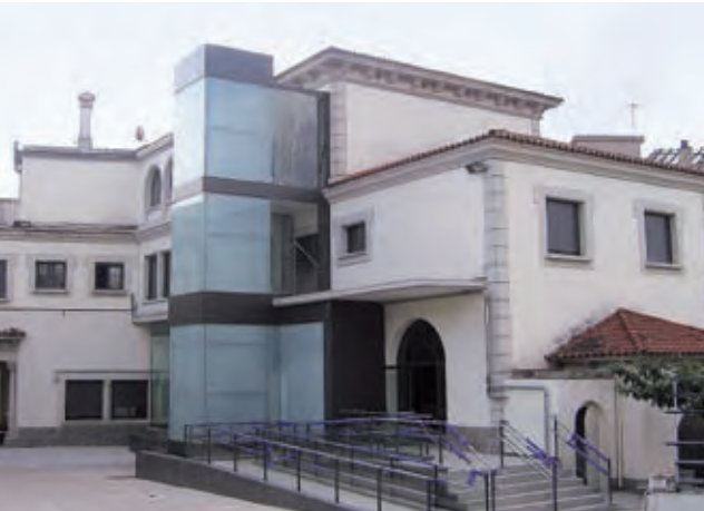
Figura 17. L'Escola de Música, després de les obres de remodelació. 2010
