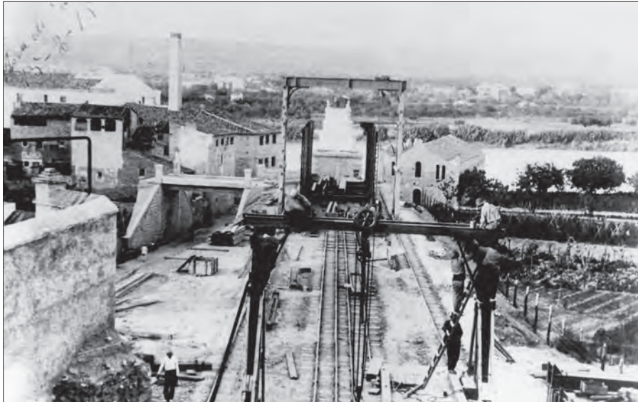
Fig. 5. Fotografia dels treballs de construcció del pont de Móra (cedida per S. Alfonso, 1915)
