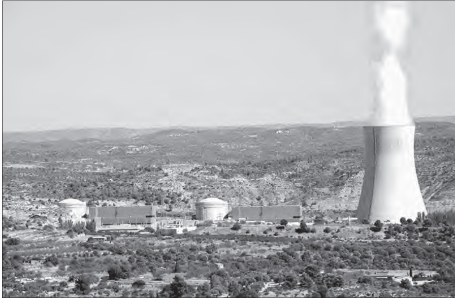
Fig. 13. Vista des dels dipòsits municipals d'aigua dels dos reactors de la Central Nuclear d'Ascó i de la immensa torre de refrigeració (2011)
