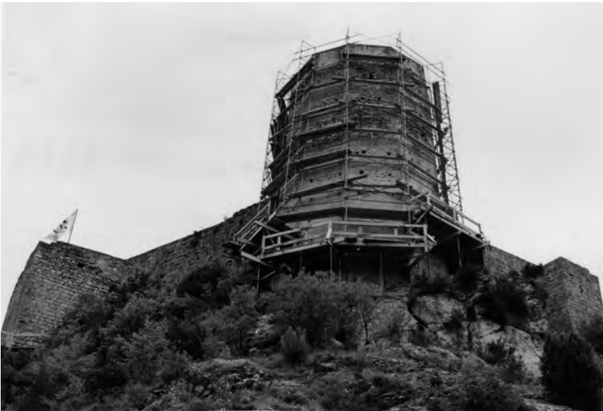
Reparació de la Torre de l'Homenatge. Foto: Andreu Miquel (1984).
