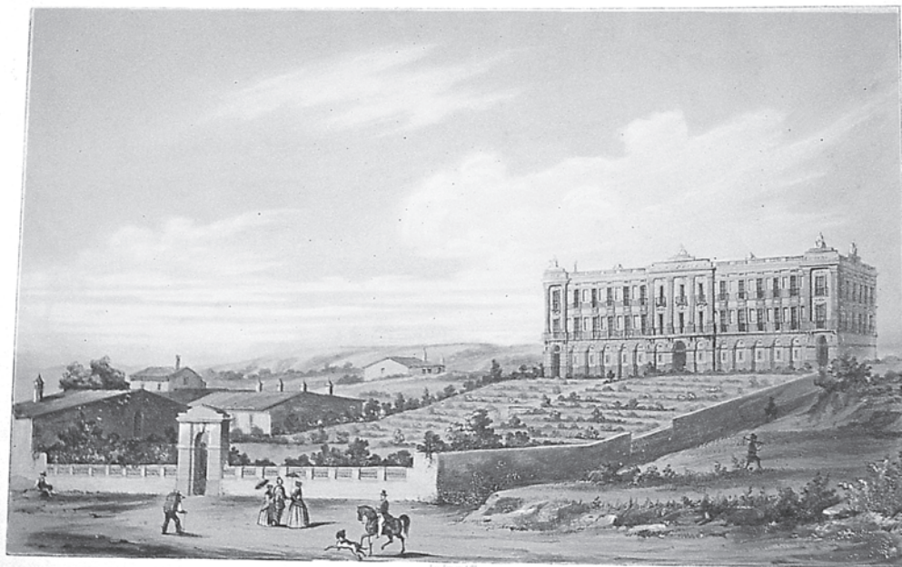
Vista al Este de la Casa propiedad de D o JOSÉ XIFRÉ y CASAS.
