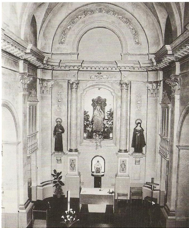
Interior de l'església de les germanes Clarisses.
