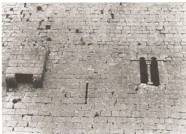
Aquesta finestra de la façana de llevant del castell s'identifica perfectament pel matacà que té a la vora: és la que ha perdut el mainell a causa d'un robatori. La fotografia va ésser feta l'agost de 1992. (Foto de Joan Badia)
