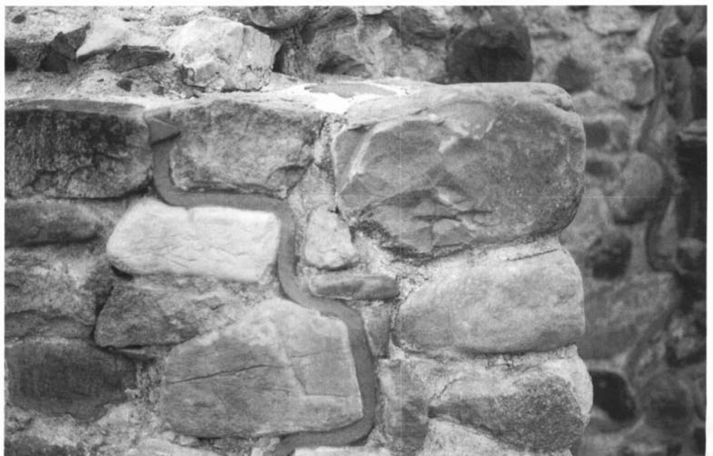
Detall d'una cinta de morter tenyit amb un triangle que indica la zona reintegrada. Fotografia: Estrat, SCP.
