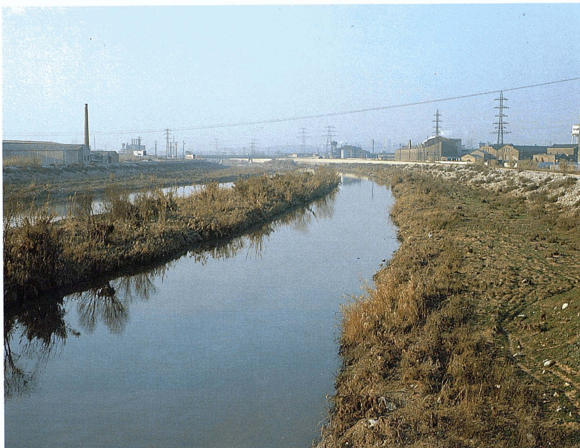
Zona final de la canalització ja feta i origen del desviament projectat.
