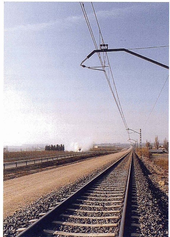
Plataforma de la nova línia d'altres prestacions. R. Moreno
