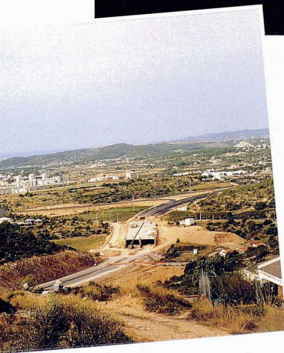
Traçat de l'autopista pel terme municipal de Sígues, amb la construcció del túnel artificial vora la urbanització Quint-mar
