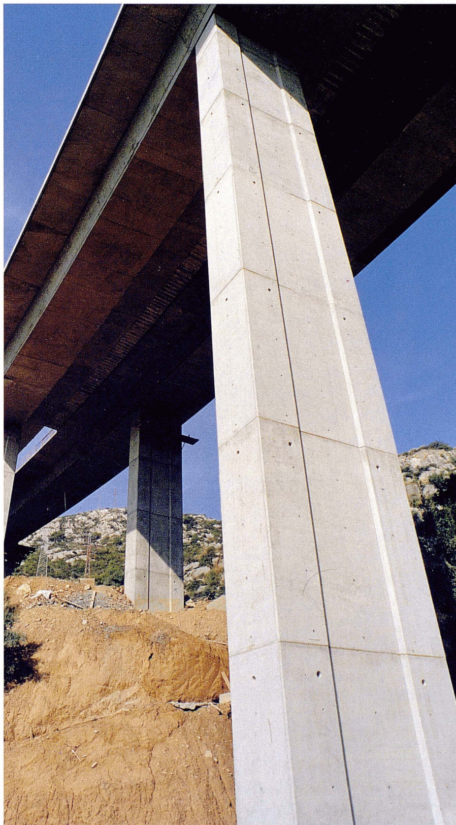
La seva pila més alta té 35 m. (El viaducte de Vallcarca arriba a 37 m de llum)
