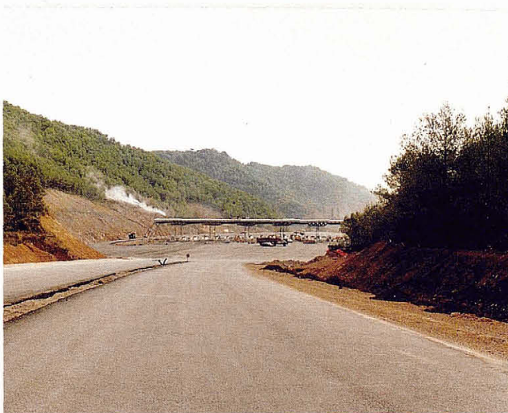
El peatge, a Vallcarca. S'estaven acabant les instal·lacions en el moment que es va fer aquest reportatge, aquest mes d'octubre
