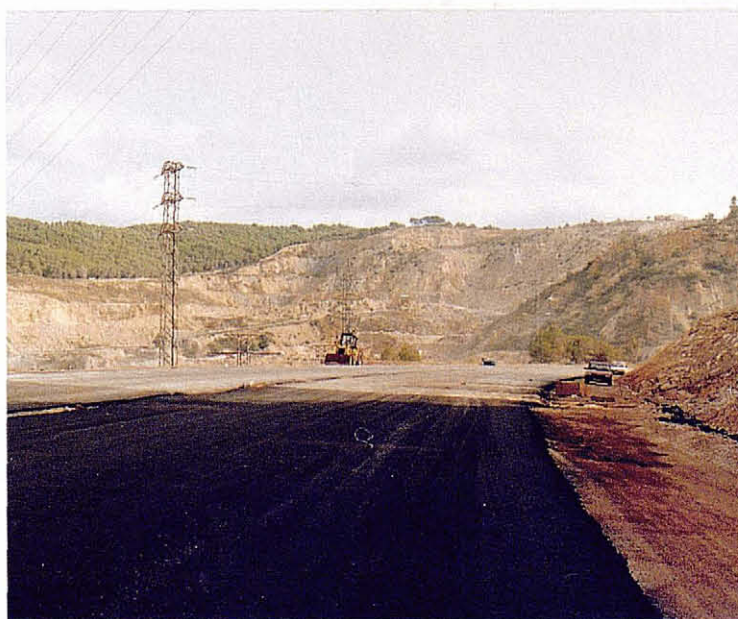
Tram de l'autopista que mostra un aspecte de la pedrera d'UNILAND, abans del túnel 4, en direcció a Barcelona
