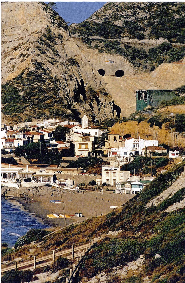
Garraf. A dalt, la boca est del túnel 4, durant la construcció
