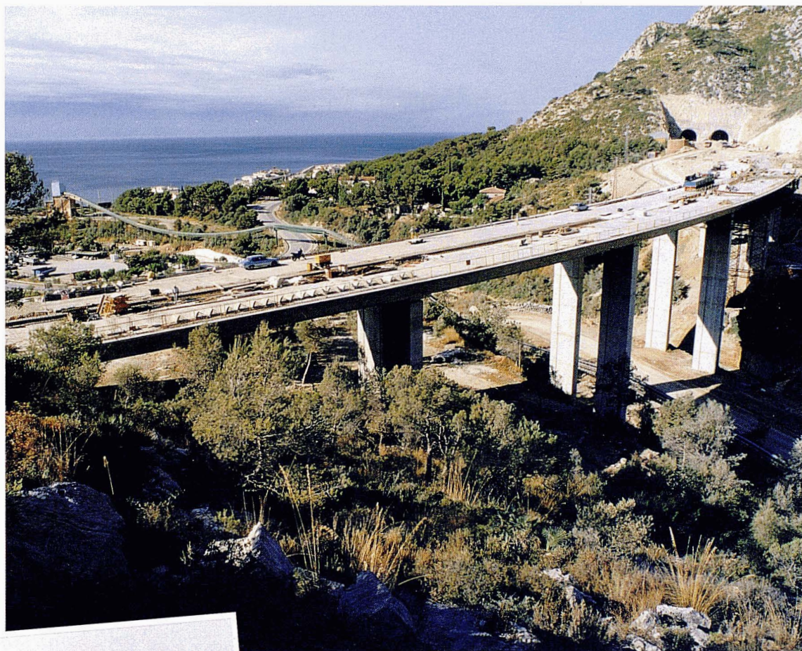
Viaducte del Garraf. Al fons, la boca est del túnel 3
