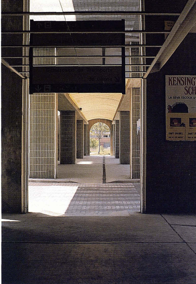
Estació d'autobusos de Girona. Vista de l'itinerari lliure de barreres entre aquesta estació i RENFE.
