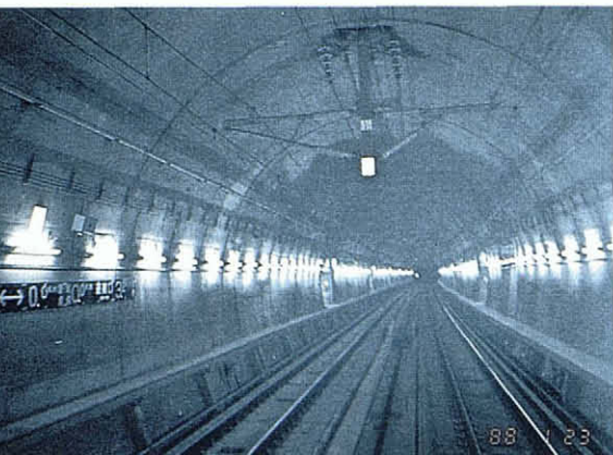
Interior i galeria d'escapada del túnel de Seikan.
