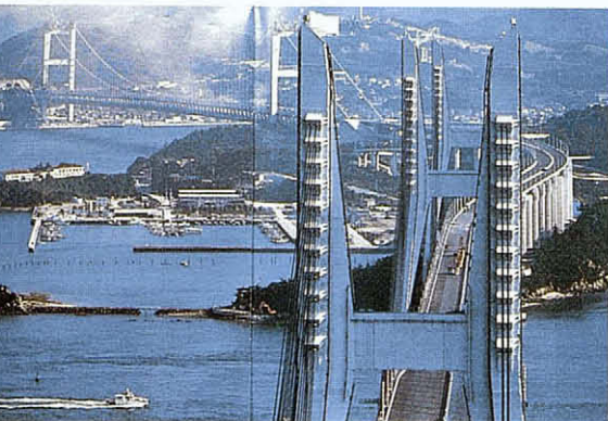
Panoràmica de l'enllaç central.
