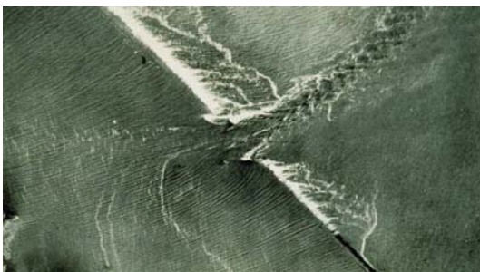
Fig. 13. Rotura de un dique de protección del río Misisipi durante la crecida de 1927. (Frankenfeld, 1927).
