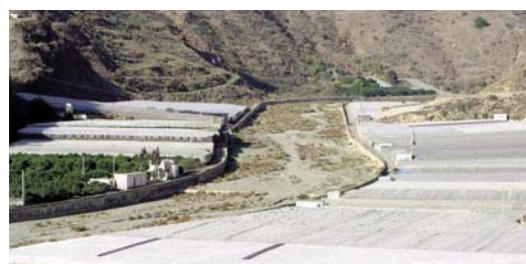
Fig. 10. Canalización en la rambla de Albuñol.
