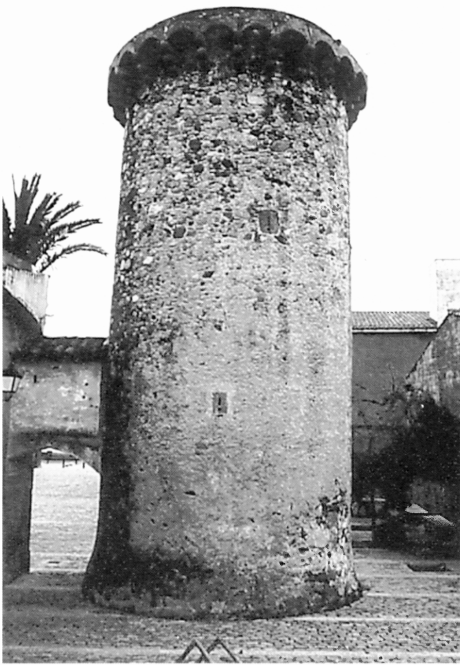
Torre de guaita d'en Nadal (Vilassar de Mar)
