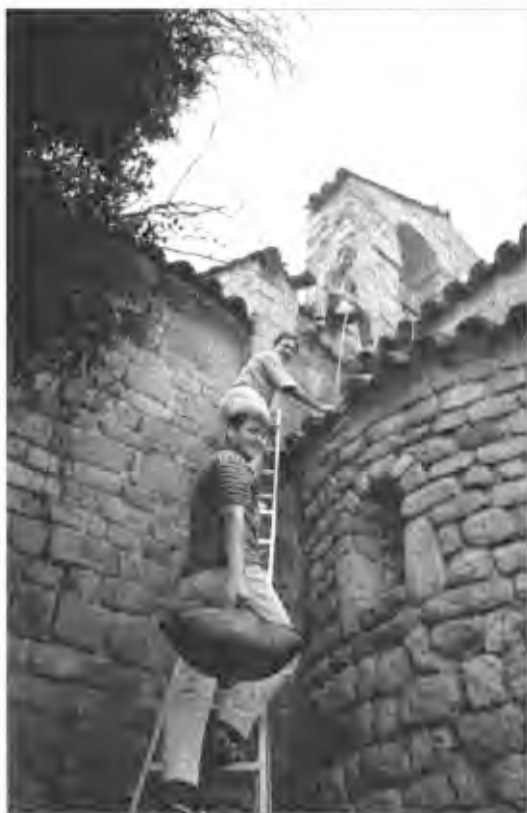
Membres del CES-AC reparant la teulada de Cabanyes
