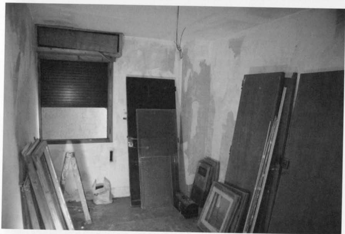
Fig. 6-7. L'habitació individual abans de la intervenció i durant les obres. © DHUB. Fotografies: Raimon Solà, Rosend Casanova i Lourdes Jansana.
