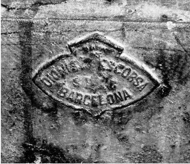
Fig. 6. Marca de la foneria Escorsa localitzada en una columna de ferro colat.
