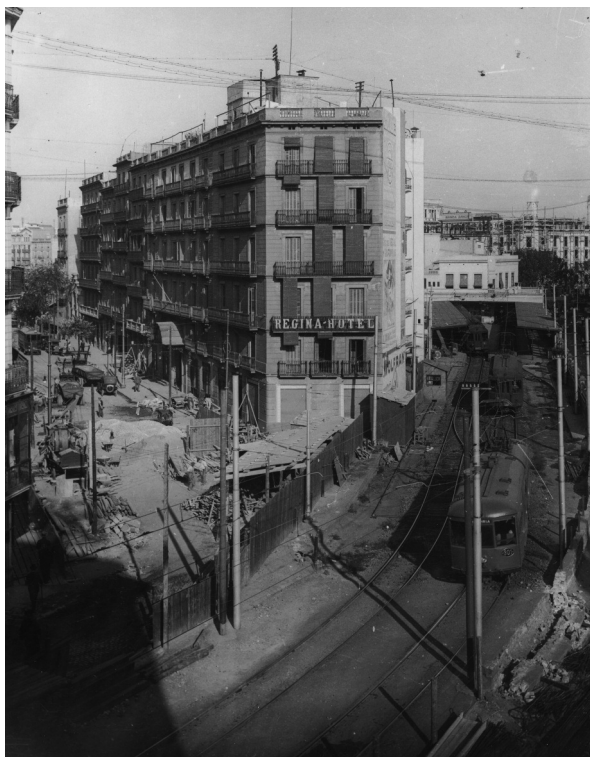
Figura 3. Obres de soterrament del tren de Sarrià a la cruïlla Pelai/Bergara. Any 1927. Foto: Arxiu Fotogràfic de Barcelona.
