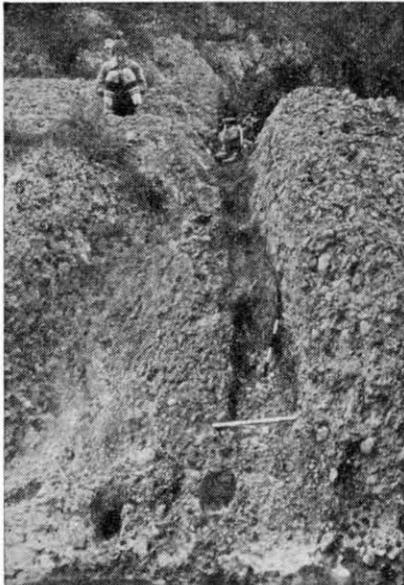
FOTO 10. Trabajo de excavación en la orilla derecha —1—. Se advierte la zona rehundida para asentar el cuerpo principal de la presa y, de izquierda a derecha, los encajes 28, B 1 y A 1.
