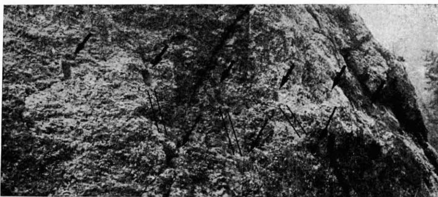
FOTO 12. Sucesión de encajes en la pared rocosa del desfiladero, que sirvieron de apoyo a la estructura del camino colgado. De derecha a izquierda, pueden verse los encajes: 8, 10, 12, 13, 14, 15, 16, 17 y 18.
