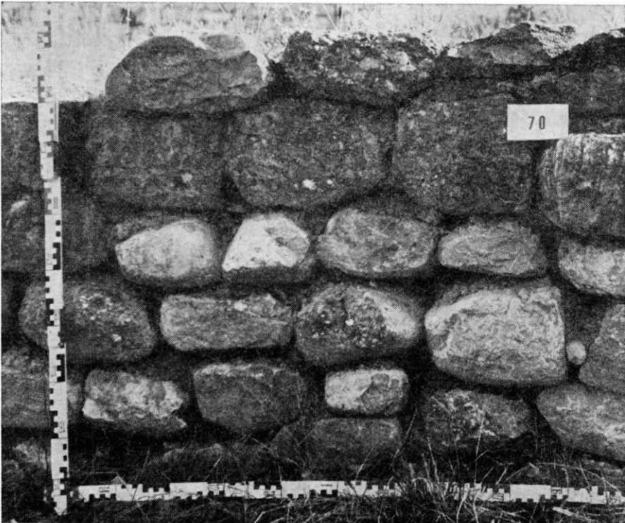
FOTO 4. Paramento del muro del siglo X. Pese a su irregularidad hay una cierta tendencia a la horizontalidad en las hiladas, que parecen alternar en grosor.
